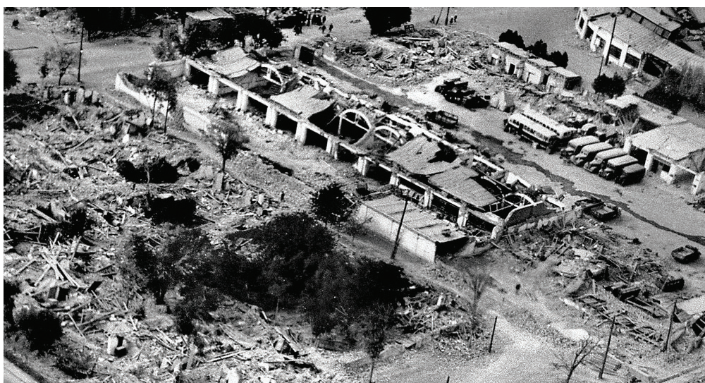
Последствия Ашхабадского землетрясения
